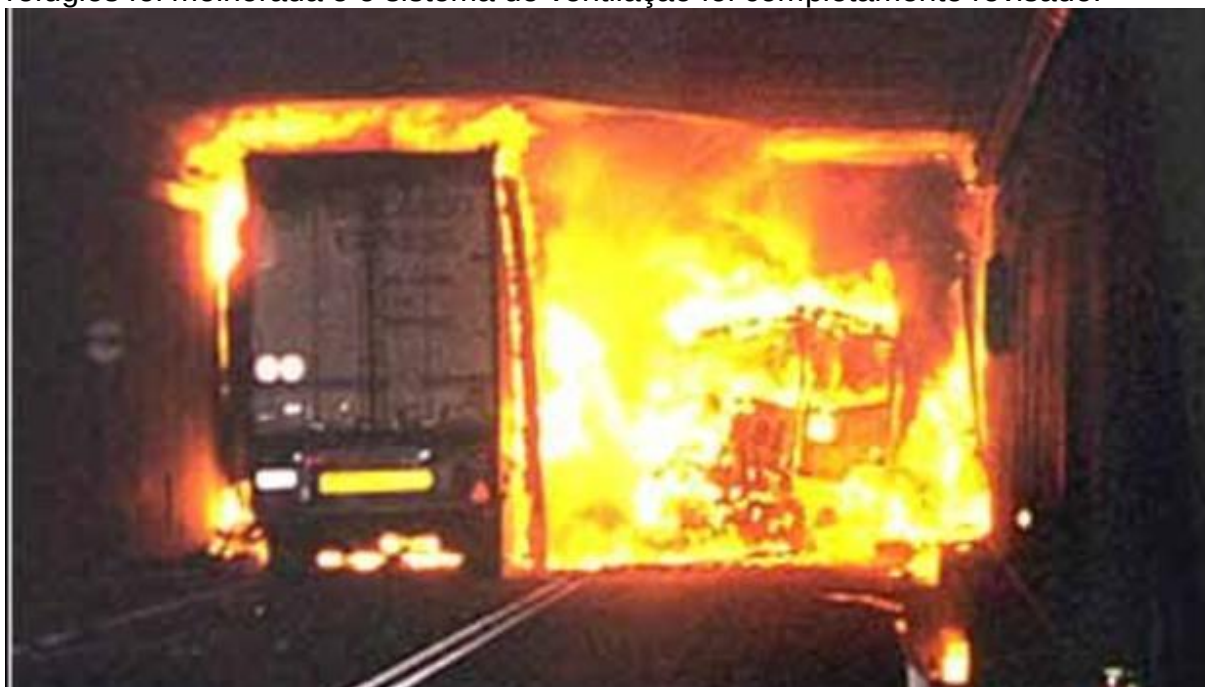
Figura 6 - Foto tirada durante incêndio no túnel São Gotardo (fonte: https://www.swissinfo.ch/ger/gesellschaft/gotthard-strassentunnel-ist-sicherer-geworden/31380918 , acessado em 03/12/2018)
